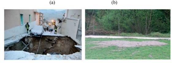
Figure 15. (a) A sinkhole in L'Aquila, and (b) liquefaction in Martini district. Şekil 15. (a) L'Aquila'da karstik bir çökme ve (b) Martini bölgesinde sıvılaşma.
